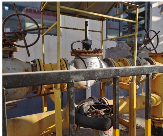
锅炉房天然气管道电磁阀手动阀
