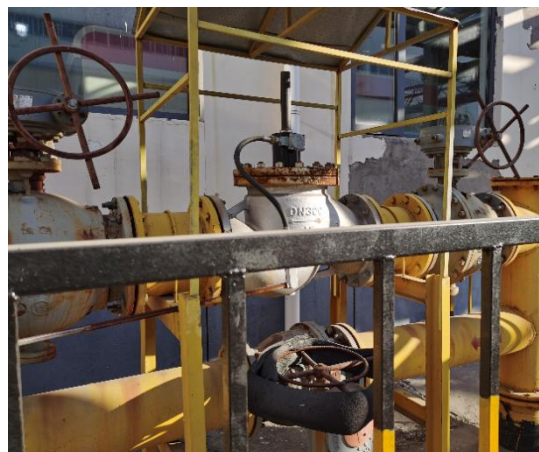
锅炉房天然气管道电磁阀手动阀
