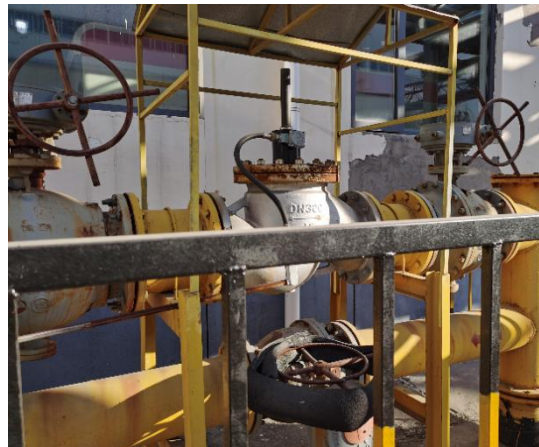
锅炉房天然气管道电磁阀手动阀
