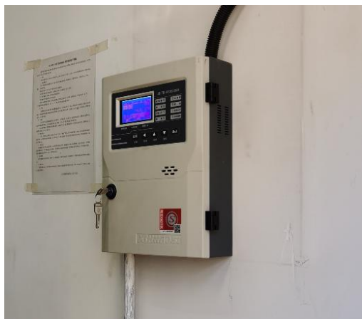
锅炉房天然气电磁阀报警装置
