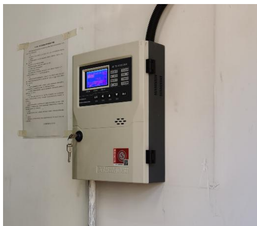
锅炉房天然气电磁阀报警装置
