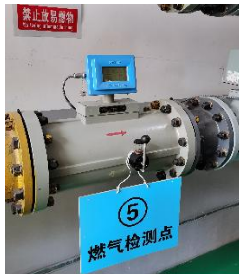
锅炉房燃气检测点
