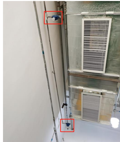
锅炉房燃气泄漏报警器
