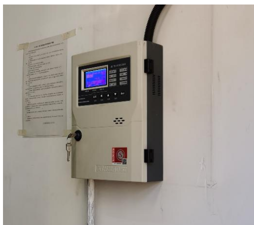
锅炉房天然气电磁阀报警装置
