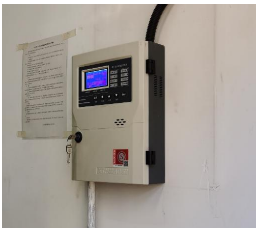
锅炉房天然气电磁阀报警装置
