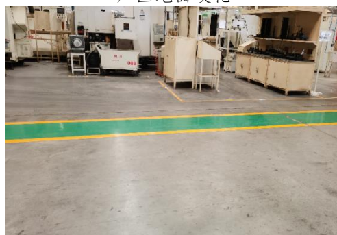
机加工车间地面防腐硬化
