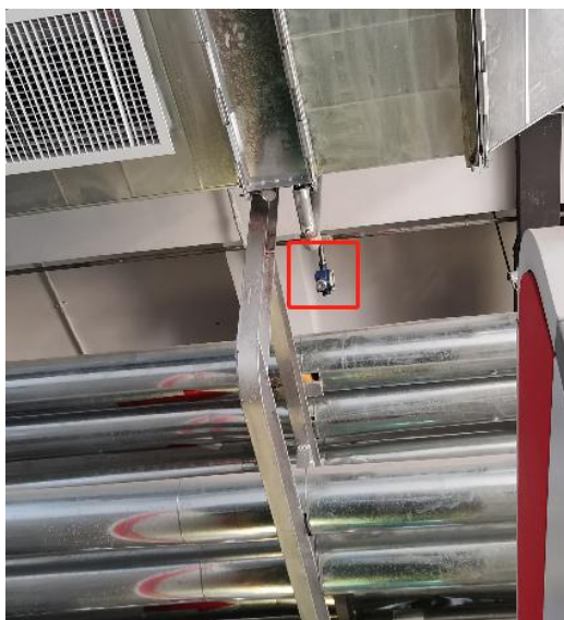
锅炉房燃气泄漏报警器
