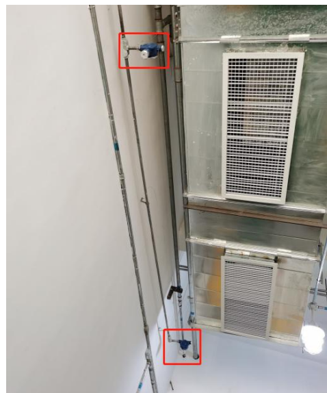
锅炉房燃气泄漏报警器
