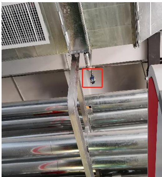
锅炉房燃气泄漏报警器
